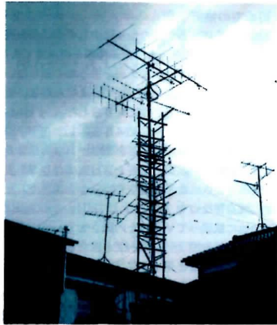
[写真6] オートバイ無線の実用化実験を契機に建てた50,144,430,1200MHz ビームアンテナ搭載タワー(16m H)
